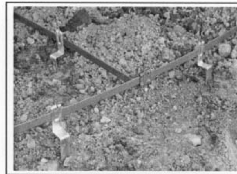
Bild 2: Abstandshalter 290 001 zur Lagefixierung des Erders
